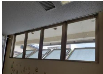
施設内各エリアの換気
