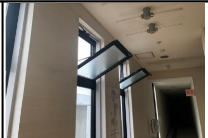
各エリア換気機器能力の向上 1時間あたり3回以上の空気の入替
